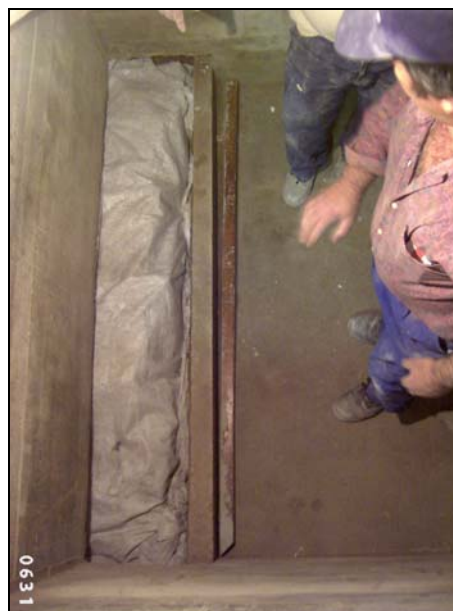
FOT. 10: col·locació del geotèxtil.
