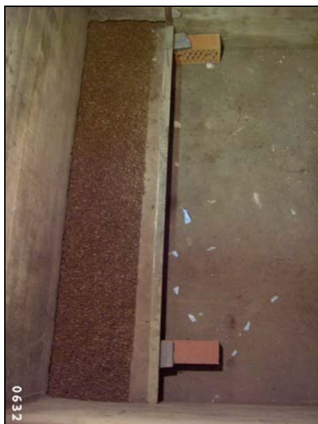
FOT. 11: col·locació de la capa de gravetes aïllants.
