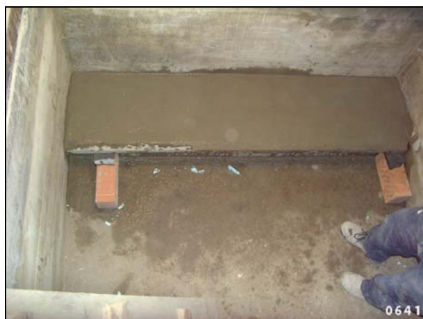
FOT. 12: cobriment final de l'estructura amb ciment.
